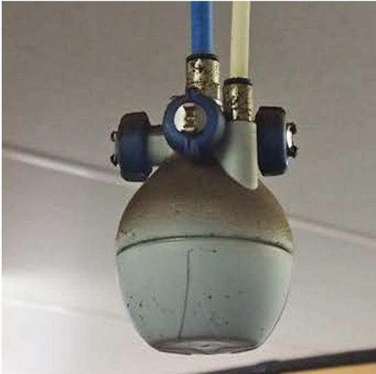
Der Sprühkopf deckt eine Fläche von etwa 50 m<sup>2</sup> ab.
